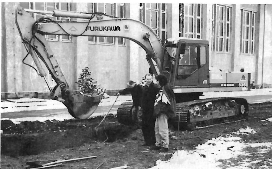
Die Bautätigkeit zur Modernisierung der Landessport- und Fußballschule Bad Blankenburg ist in vollem Gange. Immer wieder macht sich Schulleiter Rainer Milkoreit ein Bild vom Fortgang der Arbeiten.
