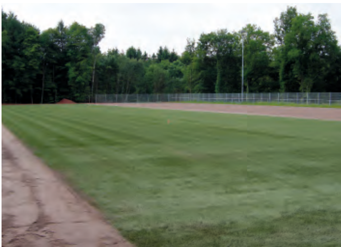
Juni: Umbau eines Tennensportplatzes mit Verlegung des Hybridrasens in der Mittelachse
