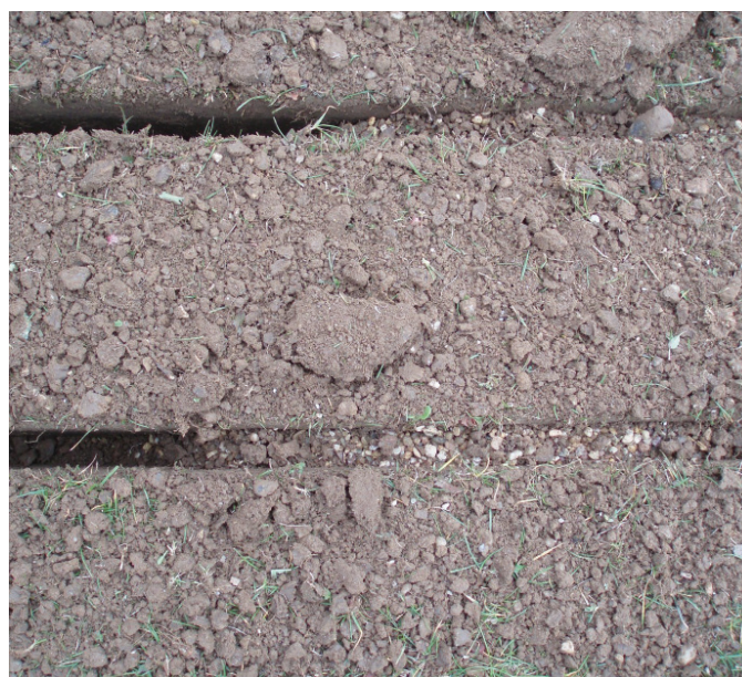
Verfüllung der Schlitze mit Kies.
