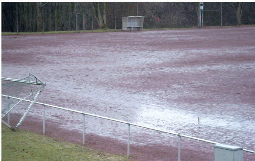
Verdichteter, staunasser Tennenbelag
