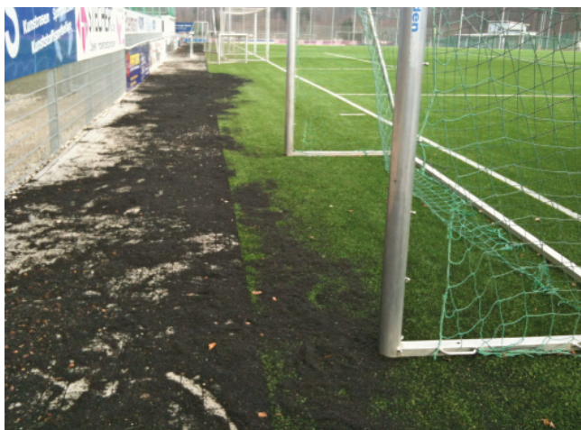
Verluste an Verfüllgranulat durch intensives Schneeschieben.
